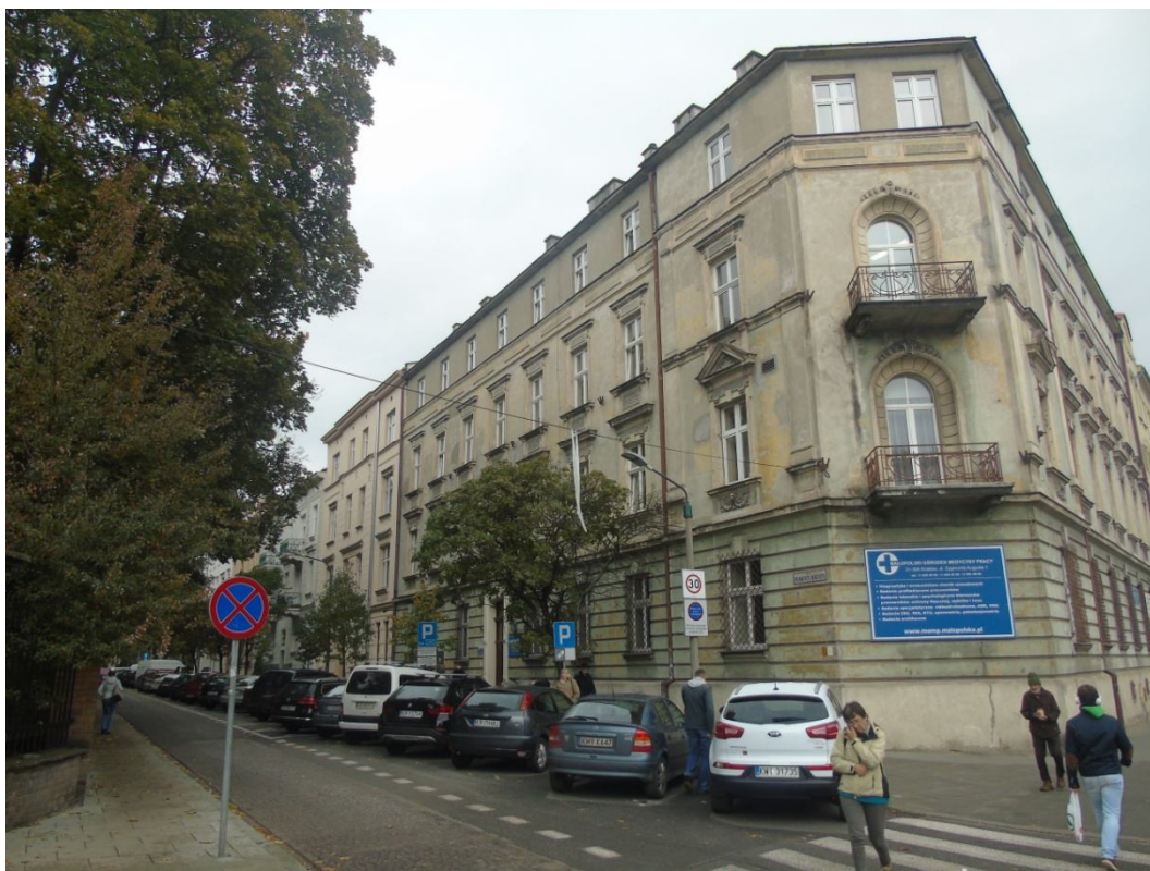
Elewacja od ul. Zygmunta Augusta
